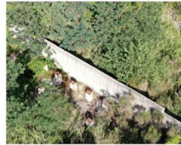
3. COSTRUZIONI IN CALCESTRUZZO ABBANDONATE
